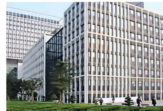
Tòa nhà Bộ Công An
